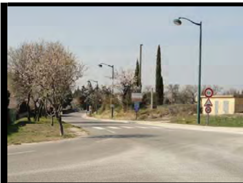
RD 43 – Est Entrée vers cave coopérative et centre village
